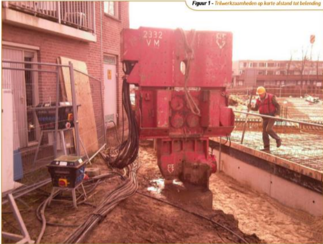
Figuur 1 - Trilwerkzaamheden op korte afstand tot belending
