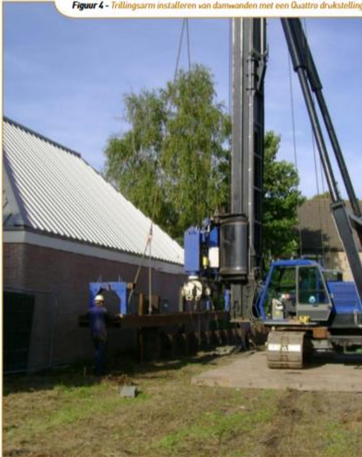
Figuur 4 - Trillingsarm installeren van damwanden met een Quattro drukstelling
