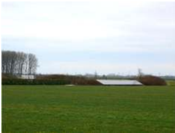
Zonnepanelen aansluitend aan het bouwvlak, voor eigen gebruik
